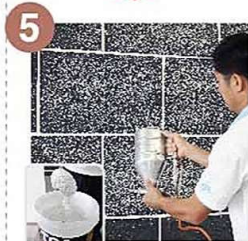
5 พื้นชั้นแรกด้วยสีทีโอเอ เดคอร์ สโตน ลวดลายเดคอร์แกรนิต ส่วนเอ (พื้นเต็ม)
