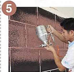
5 พื้นสีเดคอร์ลุคด้วยปืนมอร์ตา พ่นทรายในเจดสีที่ต้องการ ให้ทั่วพื้นที่
