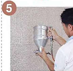
5 พื้นด้วยสีทีโอเอ เดคอร์ สโตน ลวดลายเดคอร์มาเบิล ให้ทั่วพื้นที่ โดยเริ่มจากการพ่นและเหยียดก่อน หลังจากนั้นจึงพ่นปลอยเม็ดใหญ่
