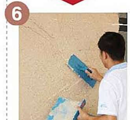
6 ฉาบสีชั้นที่ 2 ด้วยสีทีโอเอ เดคอร์ สโตน ลวดลาย เดคอร์แซนสโตน ด้วยเกรียงฉาบพลาสติก ฉาบและ ดึงทแยงให้เกิดลายน้ำ
