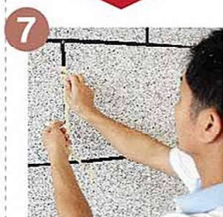
7 ดึงเทปโฟมออกแล้วพ่นด้วย น้ำยาเคลือบใส ทีโอเอ เคลียร์ โค้ท สูดรน่า
