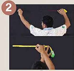
2 หลังจากรองพื้น AS Primer แห้งแล้ว ทำการกำหนดแนว โดยใช้เต้าตัด
