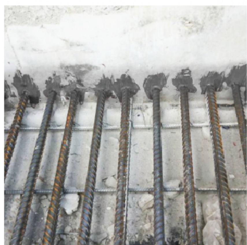
งานเสียบเหล็ก
